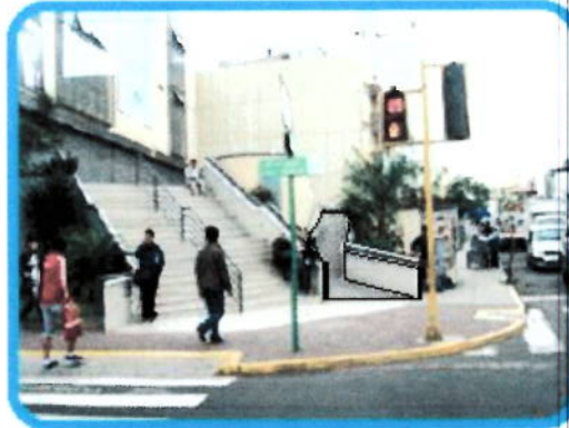
Rejilla Colocada en la acera o Vereda
