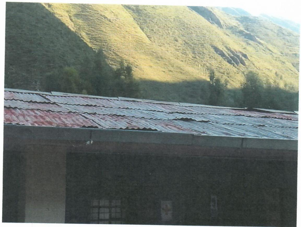
Viendo esta necesidad de urgente atención, la propuesta consiste en la continuidad del cambio de la cobertura en los techos, para lo cual se realizará el desmontaje de techos existentes, desmontaje de canaletas, para posteriormente sean colocados la cobertura con calaminón, cumbreras para calaminón y canaletas para la evacuación de aguas pluviales, todo esto en ambientes de la Jefatura de unidad académica, sala de docentes y ambientes de biblioteca.
