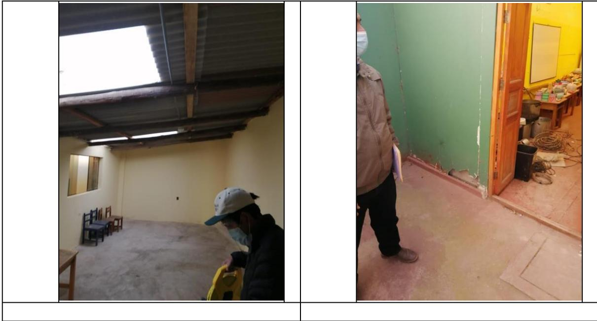
Las aulas no se encuentran en condicione óptimas para un adecuado avance de las horas lectivas de la población estudiantil debido a la falta de una adecuada cobertura, un cielo raso adecuado y un acabado de piso que pueda mantener en una temperatura estable a lo largo del día en el aula, siendo que los acabados en los que se encontró los espacios educativos impiden el avance normal debido a cambios bruscos en la temperatura.
